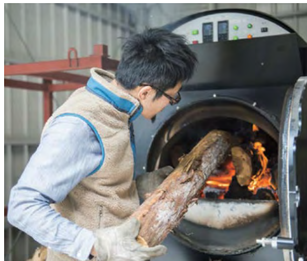
温泉施設の新ボイラー
