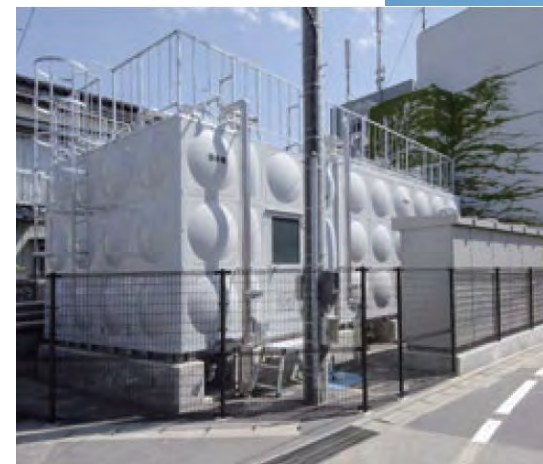
集中給湯設備
